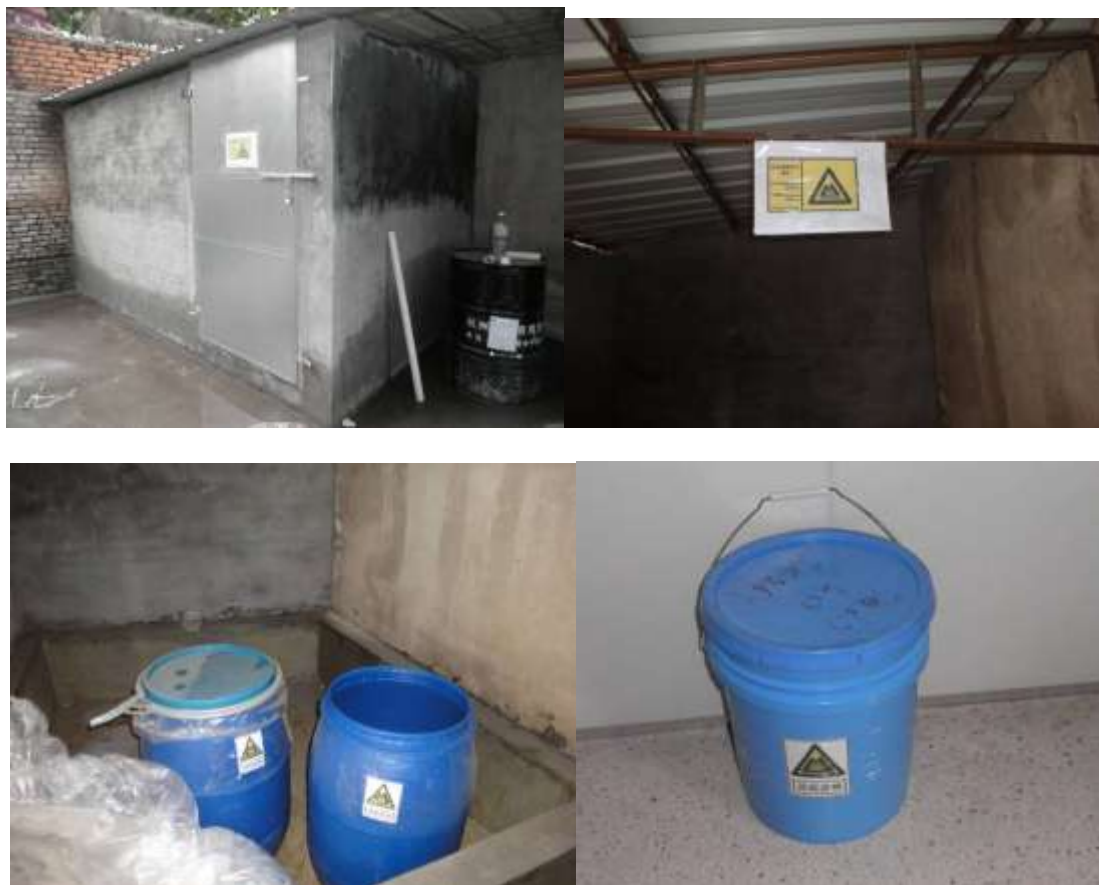
图 4-6 危险废物暂存场所照片
